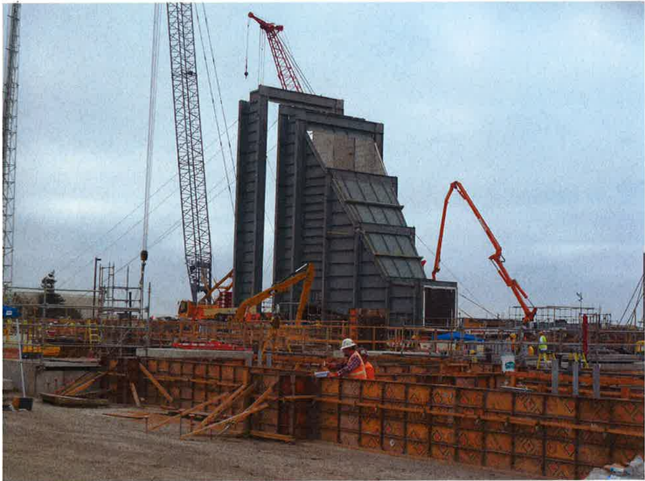
Photograph #1 HRSG #1 Framing, showing turbine exhaust entry
