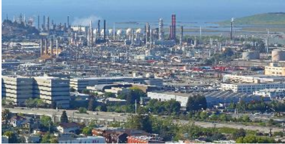
La refinera de combustibles es una fuente importante de contaminantes del aire incluida la materia particulada y los gases tóxicos
