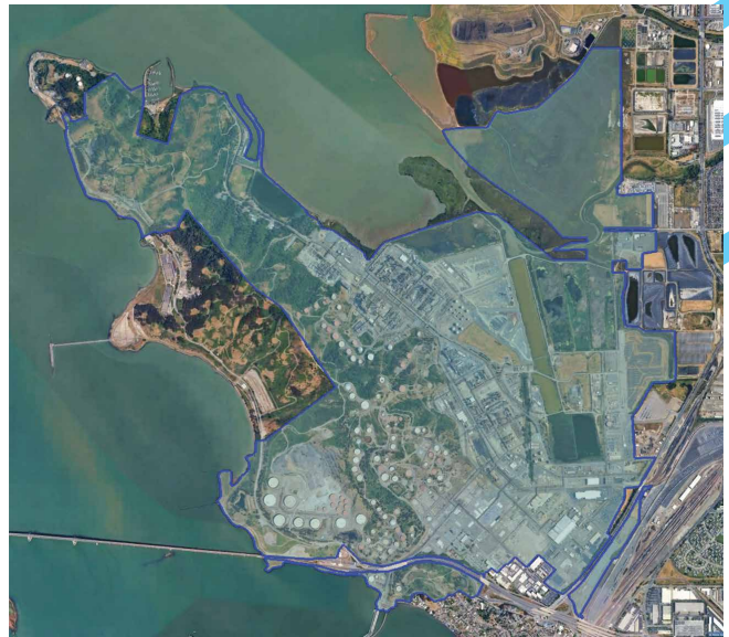
Refinery ng Chevron - Hangganan ng Pasilidad
