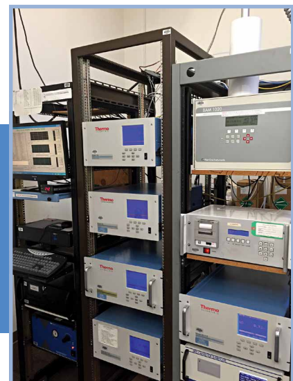
Rack de instrumentos en una estación de monitoreo de aire típica
